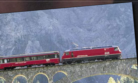
◀ RHB «HEIDI EXPRESS» auf dem 87 m hohen Wiesner Viadukt
